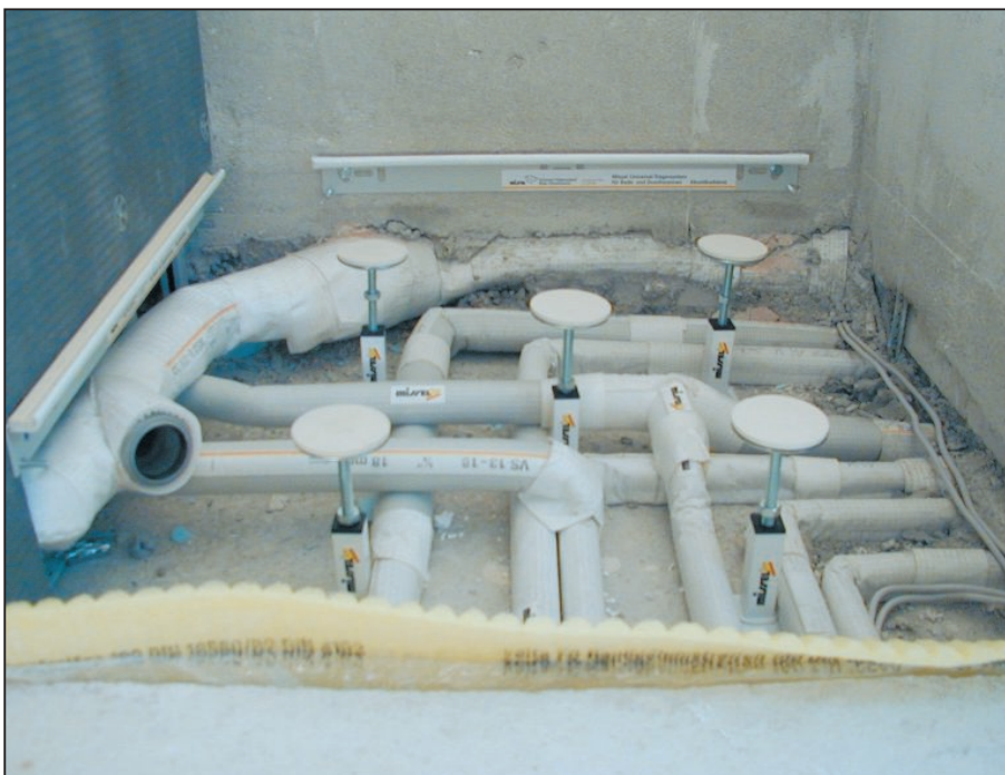
Bild 14b Verlegung von wärme- und körperschallgedämmten Rohrleitungen im Freiraum unter einer Duschwanne (mit fehlender Flächenabdichtung!)
