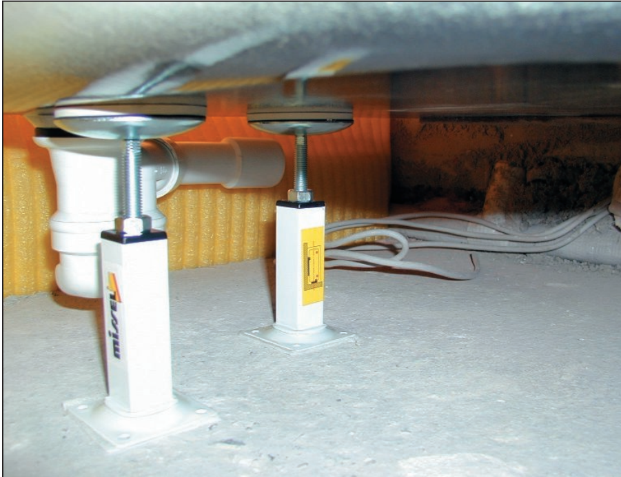
Bild 14a Freiraum zur Rohrverlegung unter den Wannen bei Verwendung des Mistel Universal-Trägersystems für Bade-, Dusch- und Whirlwannen (mit fehlender Flächenabdichtung!)
