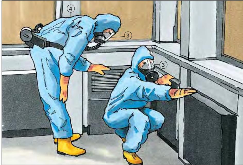
Von schwach gebundenen Asbestprodukten können auch in eingebautem Zustand Gesundheitsgefahren ausgehen, z.B. bei Beschädigung der Oberfläche. Durch Luftzirkulation können erhebliche Fasermengen freigesetzt und dadurch auch benachbarte Räume kontaminiert werden.
