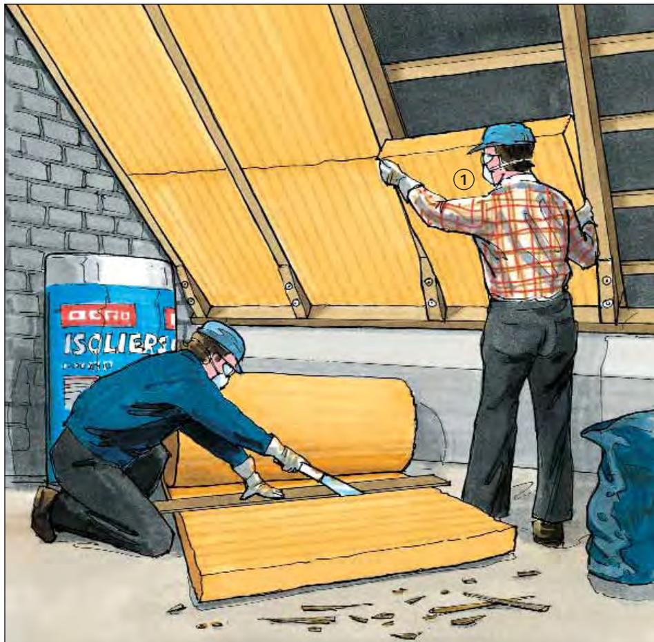
Mineralwolle-Dämmstoffe sind insbesondere als Glas- oder Steinwolle bekannt. Es handelt sich um künstliche Mineralfasern (KMF-Dämmstoffe), die bis zu 7% Kunstharz zur Formgebung und etwa 1% Öle zur Staubbindung enthalten.
