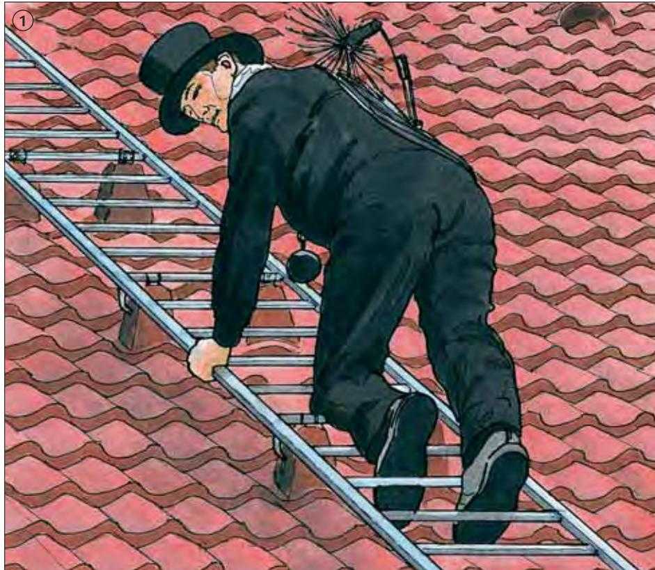
Über oder innerhalb der Dachkonstruktion für die Verkehrswege und Arbeitsplätze Bauteile aus korrosionsbeständigen Metallen verwenden.
