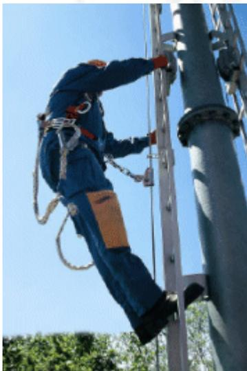
**Bild 16:** Beispiel einer Steigschutzeinrichtung mit Führung aus Stahldrahtseil
