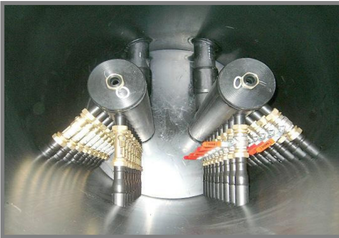
Anlage für die Regulierung von 18 Duplexsonden in einem Schacht DN 1200
