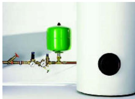
■ Bild 2: MAG-W an Wassererwärmern verhindern das dauernde Ansprechen des Sicherheitsventiles und sparen wertvolles Trinkwasser.
