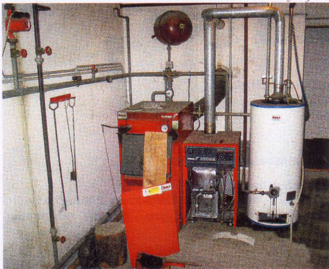
Plötzlich Wasser im Kesselhaus, nach 10 Jahren rostete der Kessel durch
