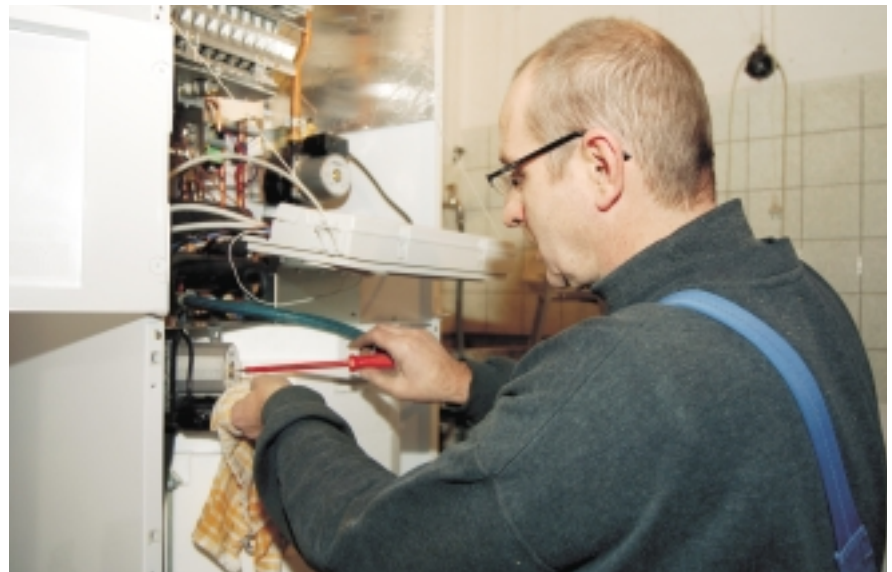
Je nach Wasserqualität empfiehlt sich schon bei der Inbetriebnahme der Heizungsanlage die Befüllung mit enthärtetem bzw. entsalztem Wasser.
