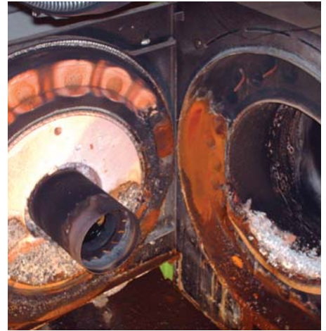
Eine Heizwasser-Analyse zeigt, wie Steinbildung, Schlammablagerungen und Korrosionsschäden vermieden werden können.
