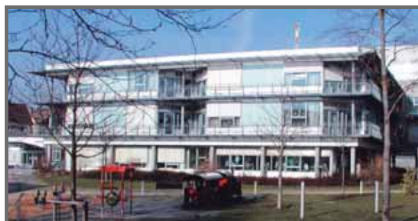
Klinikum, Säuglings- und Kleinkinderstation ausgestattet mit M-WRG
