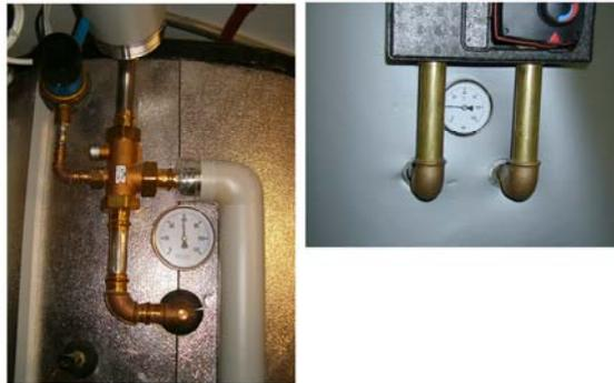
Wärmedämmung nicht durchgehend, keine Wärmesiphons
