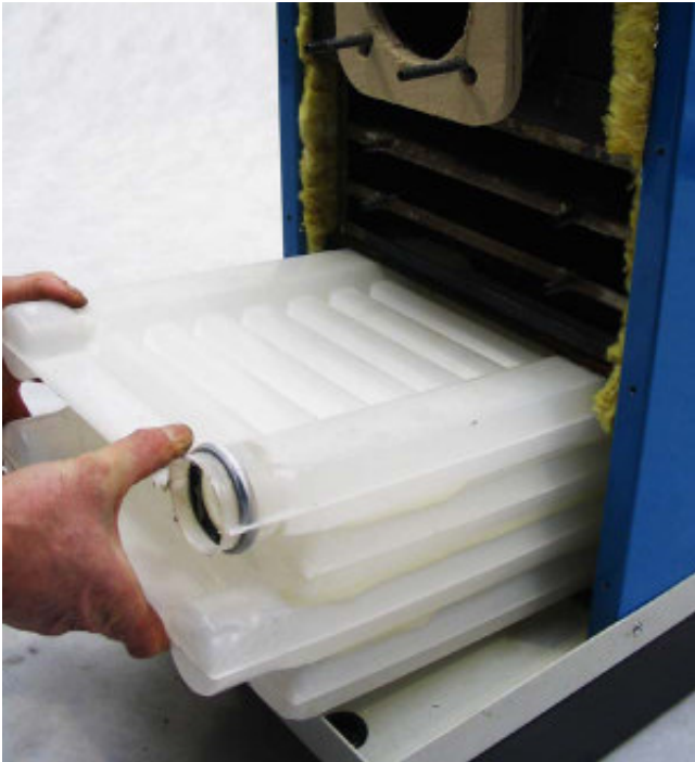
Bild 3-15: Demontage des Kunststoff-Wärmetauschers zur Inspektion/Reinigung.
