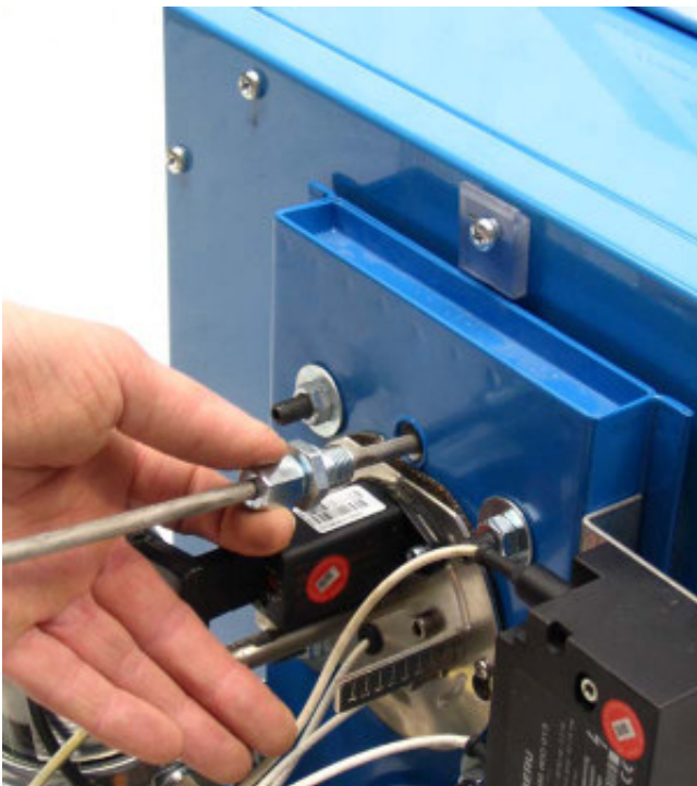
Bild 3-4: CO 2 -, Unterdruck-Messungen usw., mit zusätzlicher Messlanze in der Brennkammer.
