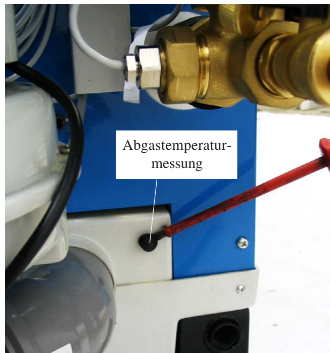
Bild 2-10: Messung der Abgastemperatur in der Bodenwanne an der Kessel-Rückseite.
