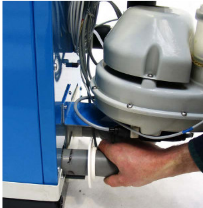
Bild 3-13: Demontage vom hinteren Zuluftrohr.
