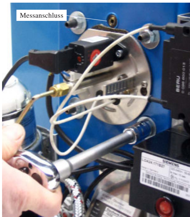
Bild 3-7: Zur Brennerdemontage die vier (4) Skt.-Mutter am Brennerflansch vollständig lösen.
