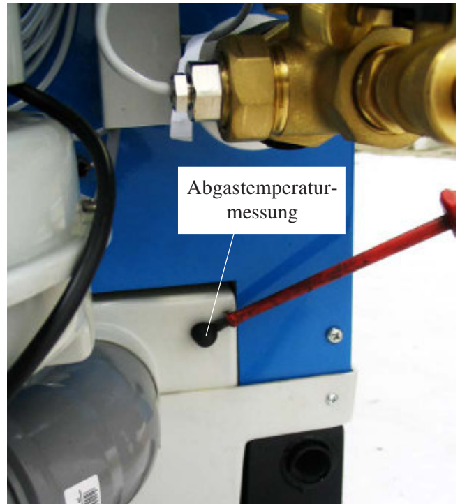
Bild 3-6: Messung der Abgastemperatur in der Bodenwanne an der Kessel-Rückseite.
