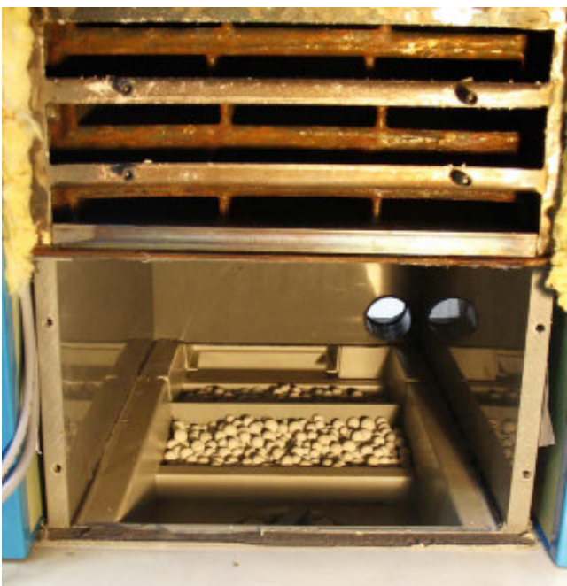
Bild 3-16: Kontrollieren der Neutralisationsanlage mit Granulatfüllung.
