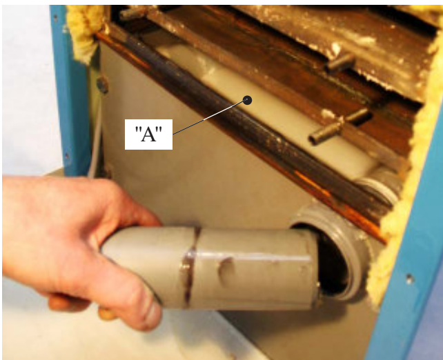
Bild 3-12: Zuluftrohr aus der Stützrahmen-Vorderwand herausziehen, zur Demontage der Stützrahmen-Vorderwand und Inspektion/Reinigung des Kunststoff-Wärmetauschers.
