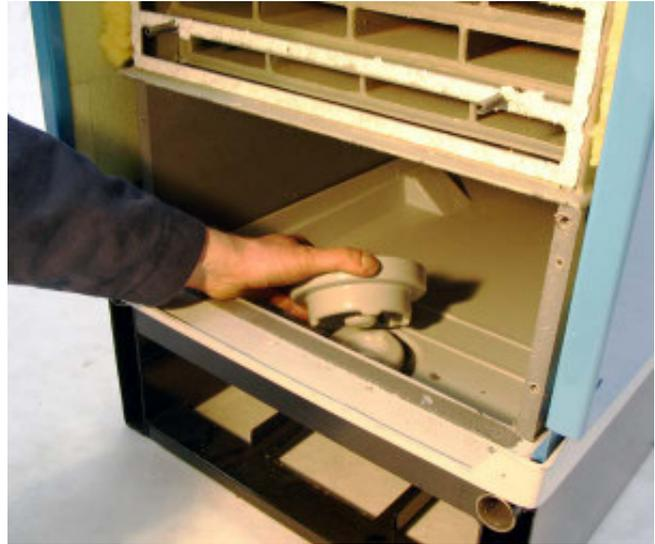
**Bild 3-17:** Inspektion/Reinigung von Bodenwanne und lose aufgesetzter Geruchsverschluss, zugänglich nach Demontage des Kunststoff-Wärmetauschers.
