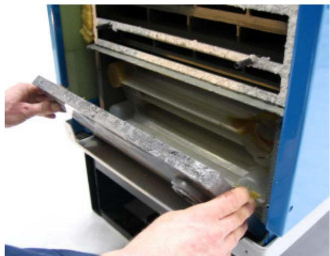
**Bild 3-14:** Abnehmen der Stützrahmen-Vorderwand zur Inspektion/Reinigung des Kunststoff-Wärmetauschers.
