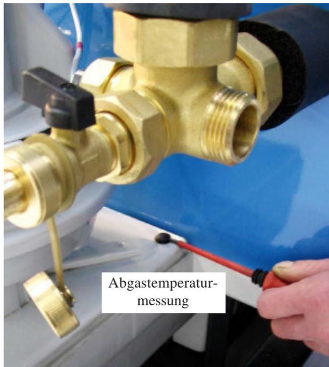
**Bild 3-3:** Abgastemperaturmessung in der Bodenwanne.
