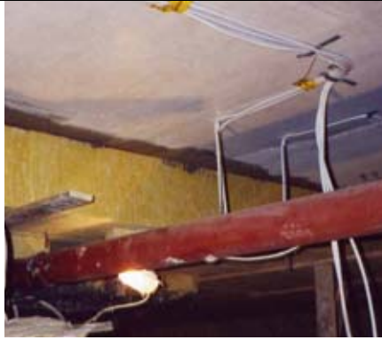
Etwa 30 cm dicke Kellerdecken- dämmung für Passivhausstandard
