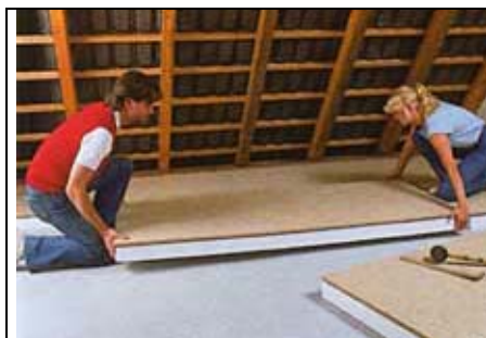
Verlegung von Verbundplatten zur Wärmedämmung (unten Dämmschicht, oben Tragschicht)
