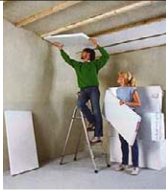
Kellerdeckendämmung mit Platten von unten (Plattenstärke 4 bis 6 cm)
