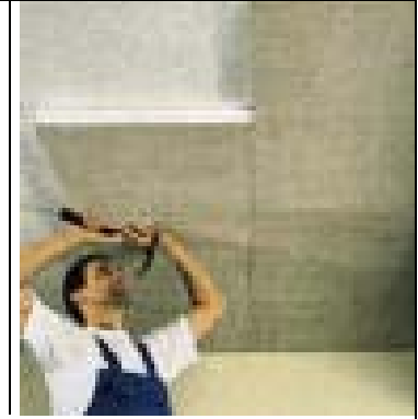
Kellerdeckendämmung mit Platten von unten (Plattenstärke 4 bis 6 cm)
