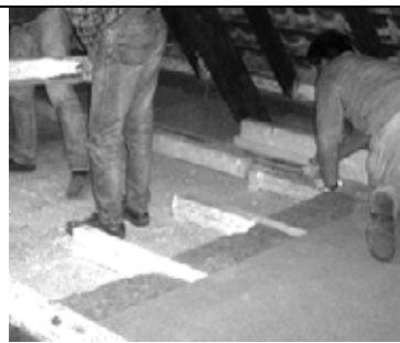
Wärmedämmung der Geschossdecke mit separaten Dämmbahnen und darüber Holzplatten
