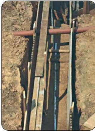
**Bild 1: Fehlerhaft eingebrachte Fundamenterder**
